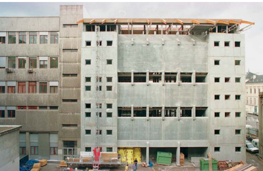
Le bâtiment de la bibliothèque en construction © Service Archives, MOM
